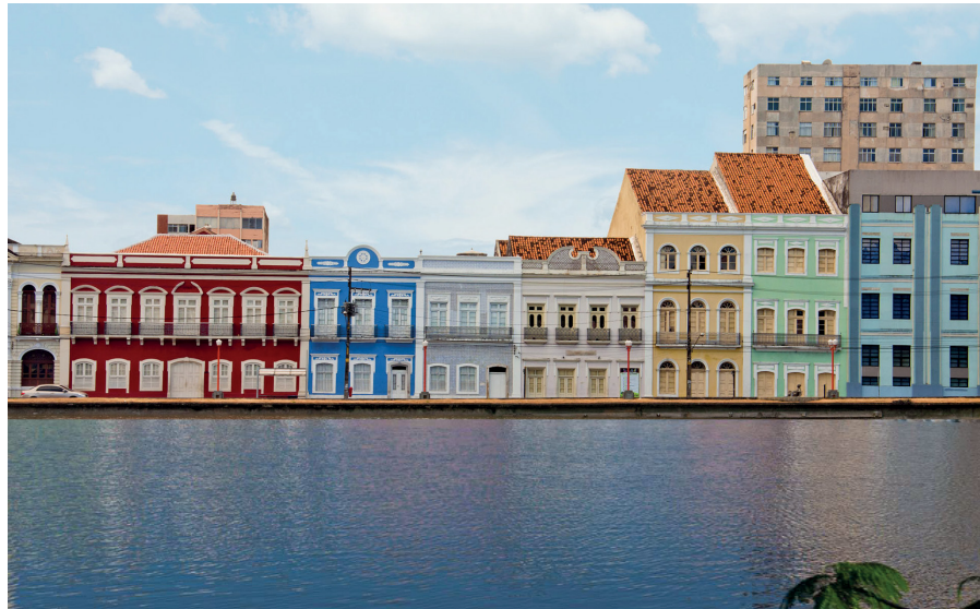
Fig 1 Rua da Aurora e sede da Fundarpe, nº 463 Fonte: Acervo da Fundarpe
